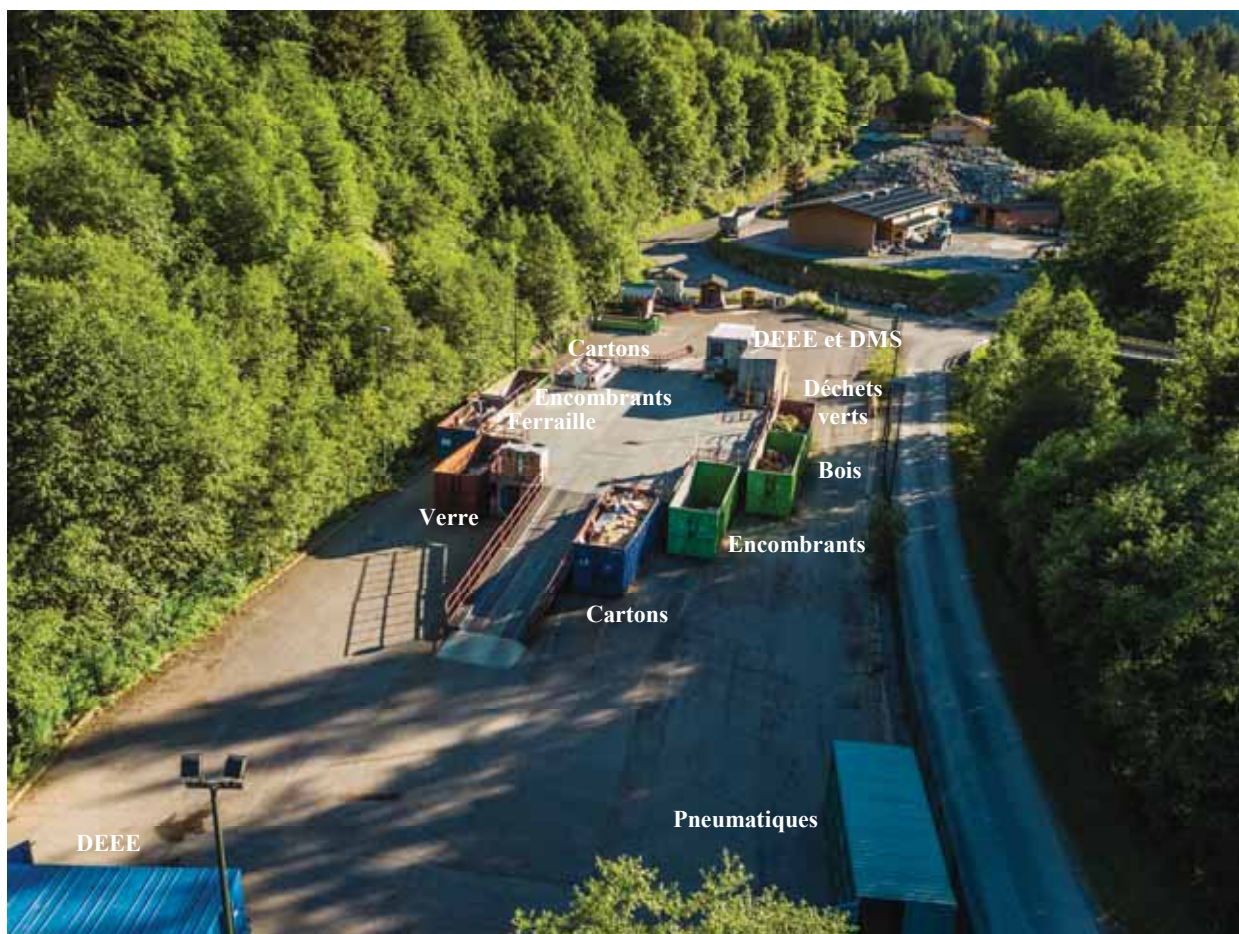
Photo 7 : vue aérienne de la déchèterie des Gets
