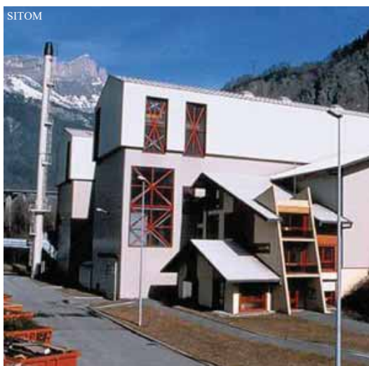
Photo 2 : usine d'incinération de Passy
