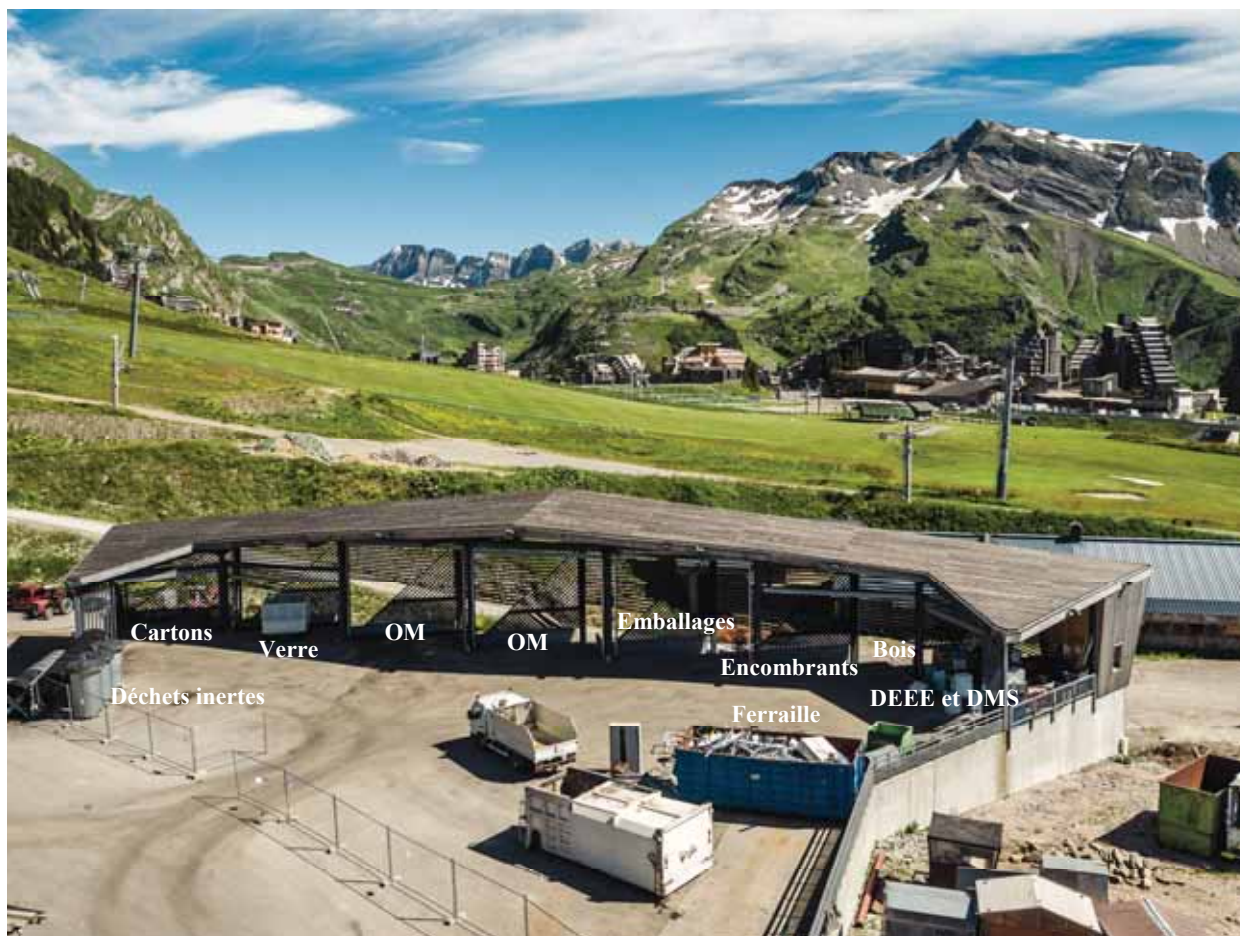
Photo 6 : vue aérienne de la déchèterie d'Avoriaz
