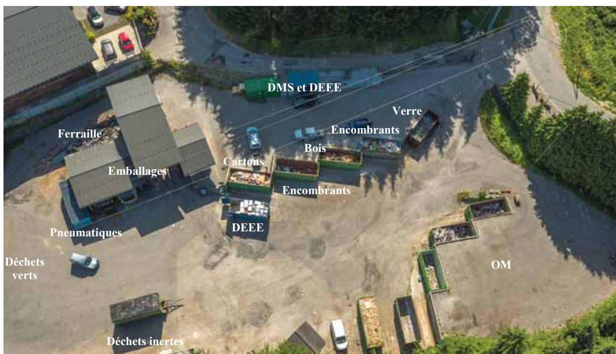
Photo 5 : vue aérienne de la déchèterie de Morzine
