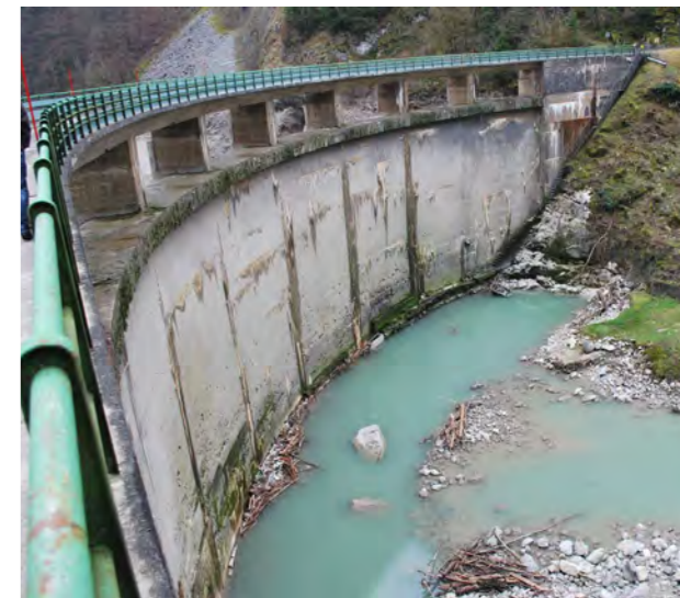
Barrage du Jotty.
