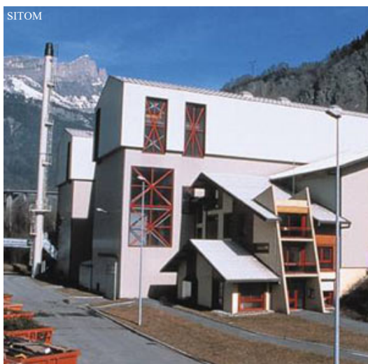
Photo 2 : usine d'incinération de Passy
