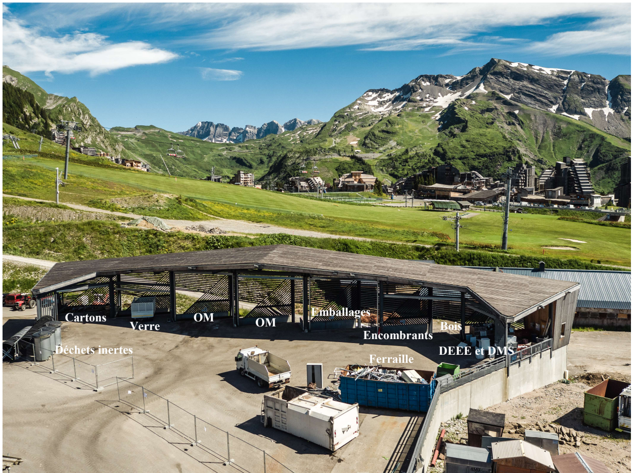
Photo 6 : vue aérienne de la déchèterie d'Avoriaz
