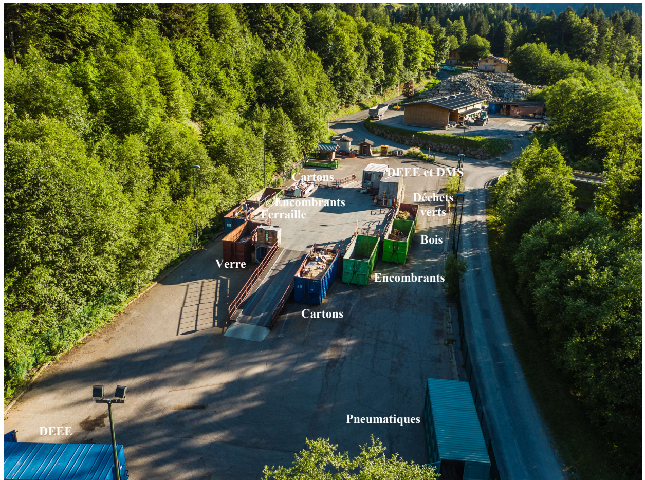
Photo 7 : vue aérienne de la déchèterie des Gets
