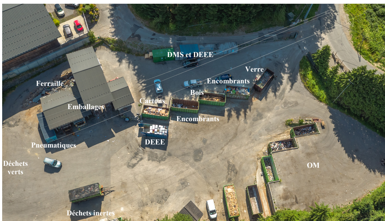
Photo 5 : vue aérienne de la déchèterie de Morzine
